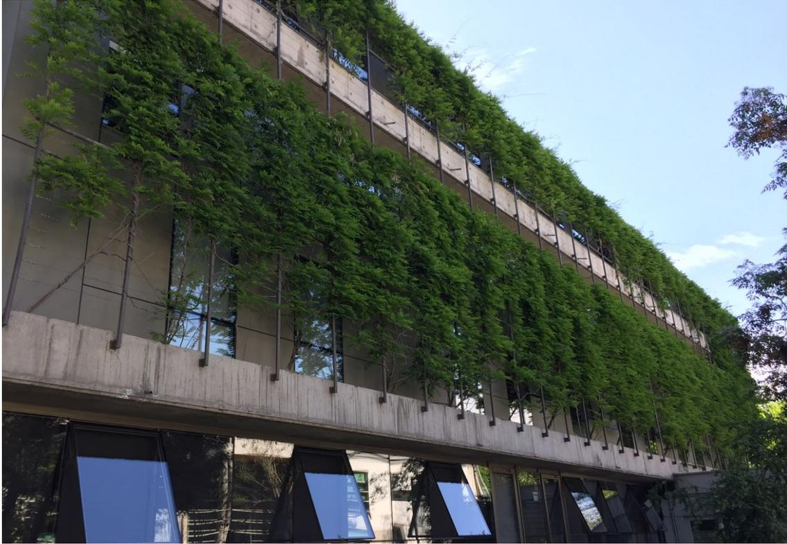
**Figura 1.9.** Ejemplo muro vegetativo con plantas trepadoras: fachada oriente: edificio Escuela de Construcción Civil, Campus San Joaquín, Pontificia Universidad Católica de Chile.
